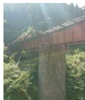
写真-8 JR肥薩線鉄橋
