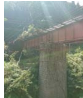
写真-9 JR肥薩線鉄橋
