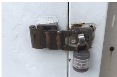
図8 修繕後の施錠部分
