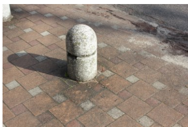
図1 車止めの石柱
