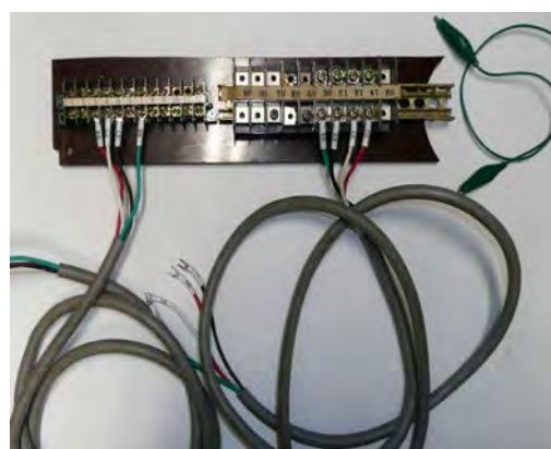
図 3 配線に使用したケーブル類
